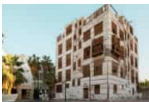
**٤- الخشب :** يستخدم الخشب في مختلف أنواع البناء التقليدي وخاصة للتسقيف والطمام ولصناعة الأبواب والتواقد والأوتاد التي تثبت في الجدران ، كما يستعمل في صنع الرواشين ، كما في الشكل (٥٣) .
